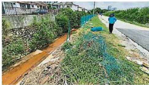
学校与住宅区相隔的排水沟的围篱, 也进行重新修建。(陈狄源提供)。
